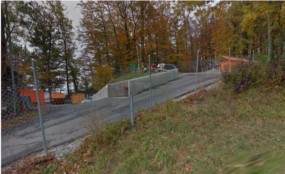
Figure 19 : Déchetterie (source : Google Street View).
