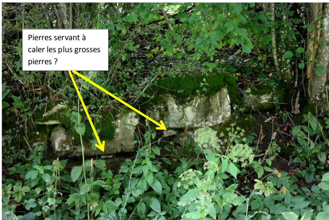
En contre-bas, côté Marais: empièchement évoquant les vestiges d'un mur (?) Dim. des blocs env. 80 x 50 sur 30 cm hauteur
